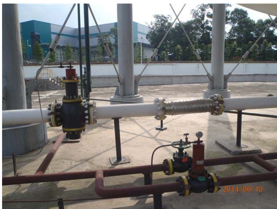
图 液相管线补偿器
