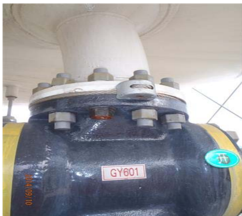
图 罐底根部阀带压堵漏
